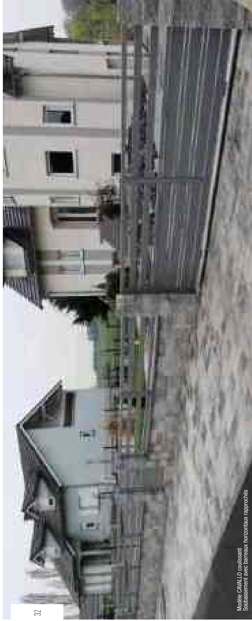
Couissant antagoniste Avec 1 montant central par vantail à partir de L > 5 m Couissants télescopique et autoportant : non réalisable
